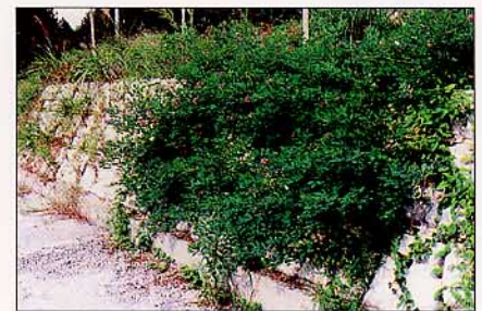
施工後1年6ヶ月
