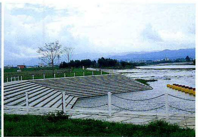
北海道 石狩川河川環境整備工事
