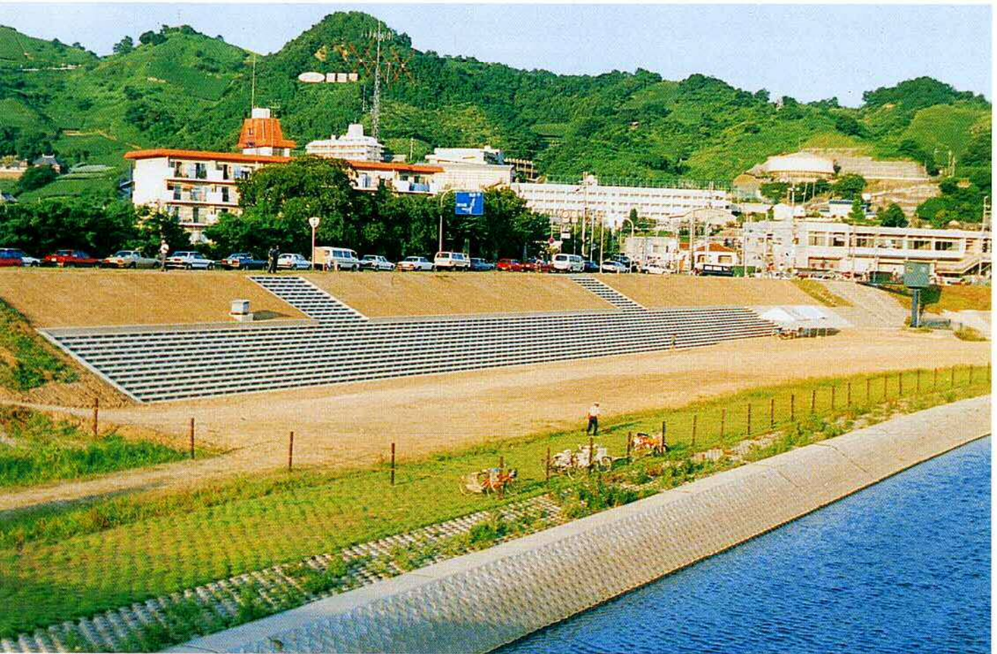
大阪府 大和川改修工事
