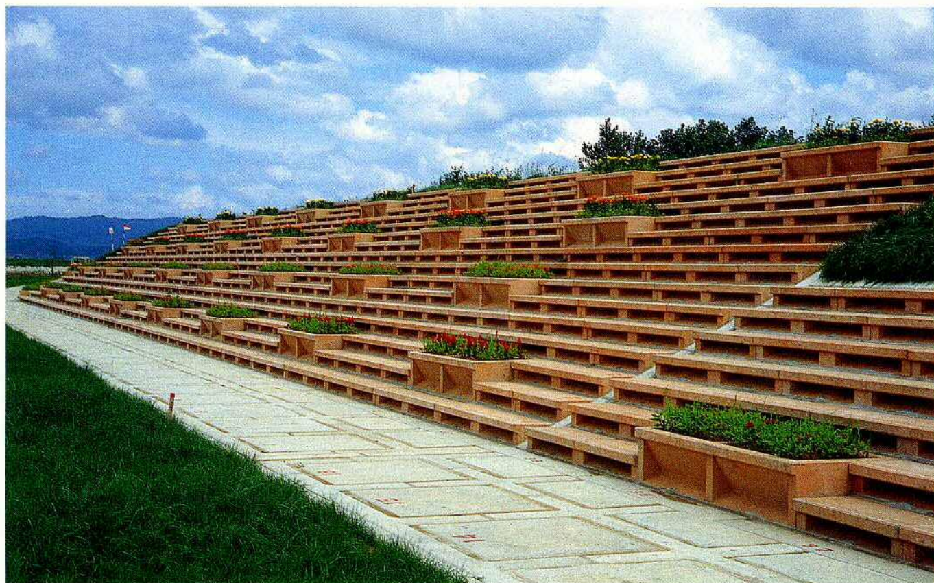
北海道天塩川河川改修工事
