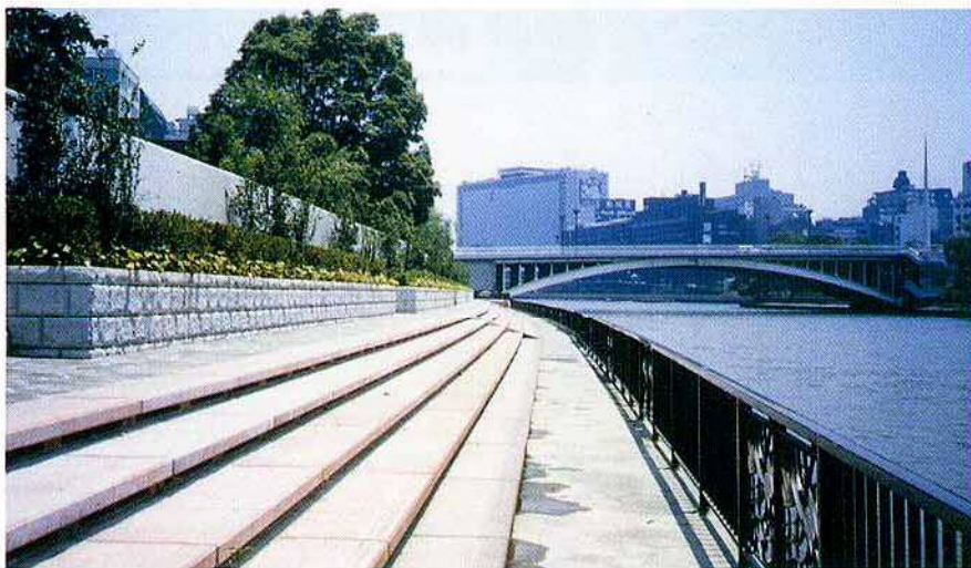
大阪府 堂島川河川改修工事
