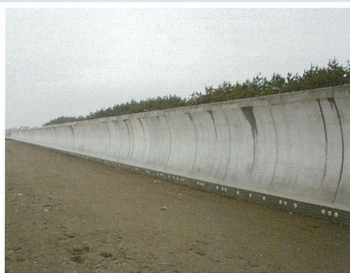
海岸災害復旧工事(千葉県)
