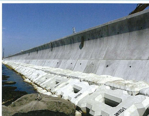
治山施設災害復旧(新潟県)
