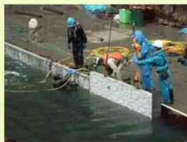
パネル取り付け施工
