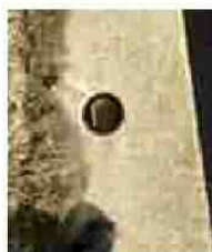
笠コン天端削孔及び充填Co打設
