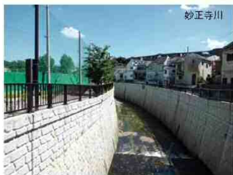
パネル取付け完了
