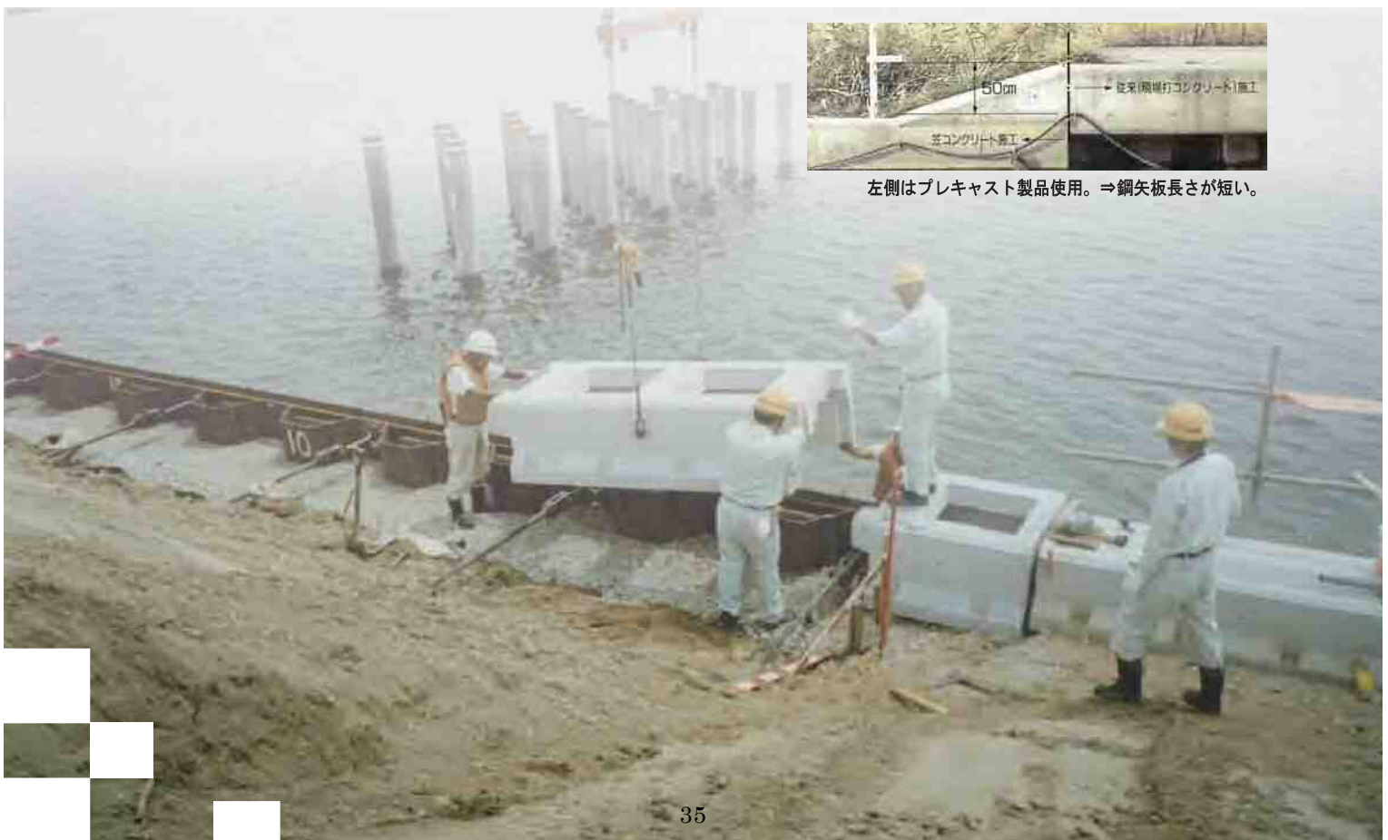
底板プレート設置状況 (実用新案・意匠登録済)
