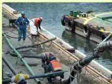
間詰めコンクリート打設
