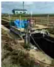
笠コン天端削孔及び充填Co打設
