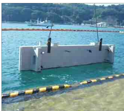
2. 残置型枠吊り状況
