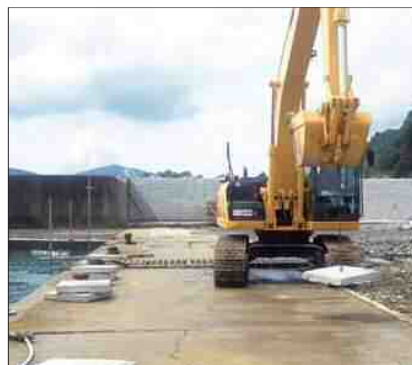
基礎工（敷パネル）の設置状況
