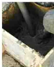
笠コン天端削孔及び充填Co打設
