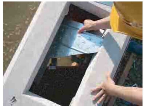
底板プレート設置状況 (実用新案・意匠登録済)
