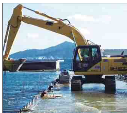
3. 残置型枠の水中布設
